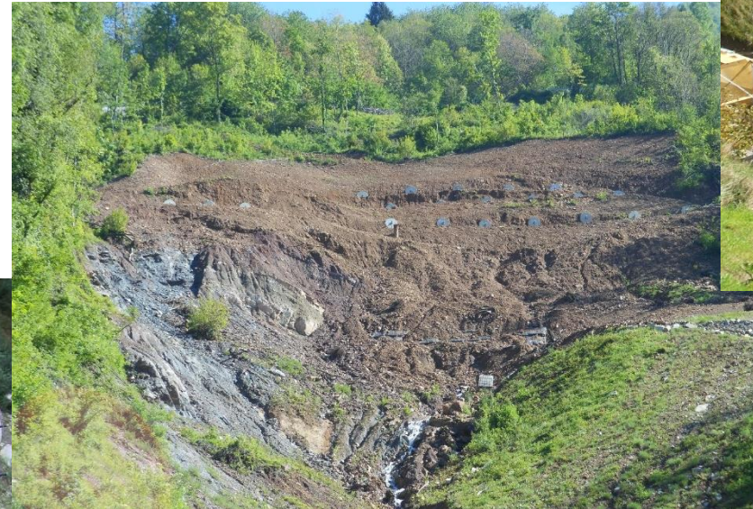
Val di Maso landslide (Valli del Pasubio, VI)
