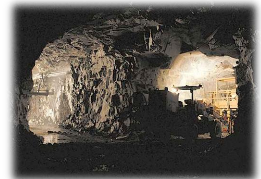
Stabilità degli scavi
