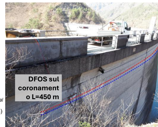
DFOS per l'analisi delle deformazioni della struttura e delle fondazioni di una diga ad arco / ancoraggi compositi
